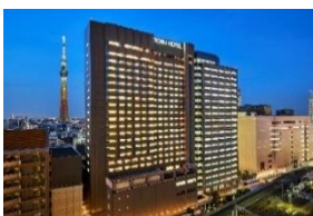
東武ホテルレバント東京 外観
